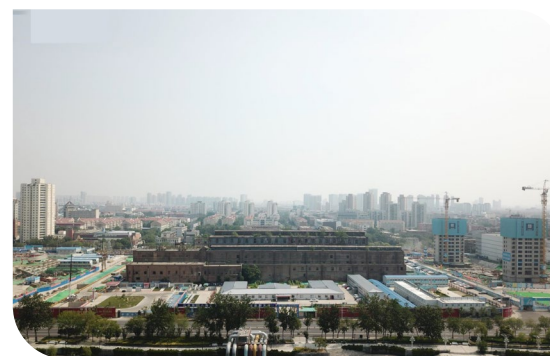
天津第一热电厂改造前
