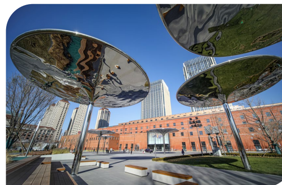
河畔广场光伏伞
