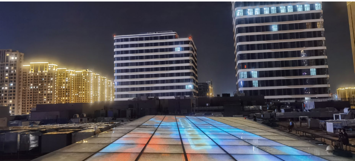
青岛金茂览秀城北区采光中庭光伏顶
