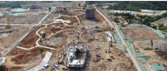
水晶化工一期治理后现场
