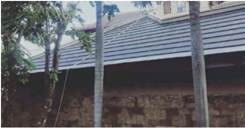
三亞金茂麗思卡爾頓酒店：採用灰色光伏瓦產品 + REC 電池 + 自研光伏瓦系統，裝機容量 4.6kW
