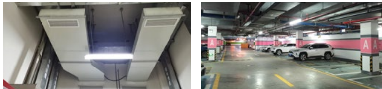
空調升級改造施工現場
