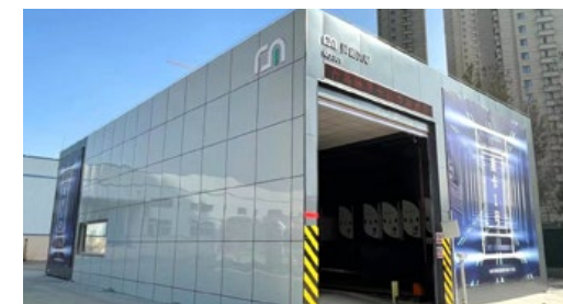
青島港換電站：山東省內首個投入示範運行的重卡換電站標桿項目
