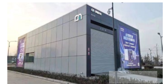
新鄭機場換電站
