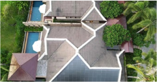
三亞金茂麗思卡爾頓酒店：採用灰色光伏瓦產品 + REC 電池 + 自研光伏瓦系統，裝機容量 4.6kW
